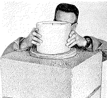
Fig. 7. Det mures 2 stk. Leca elementer — montaselokket tas opp — deretter fylles med mineralull og teglforing.
