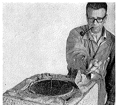
Fig. 6. Montasjelokket legges oppå for å oppta mørtelspill fra videre muring.
