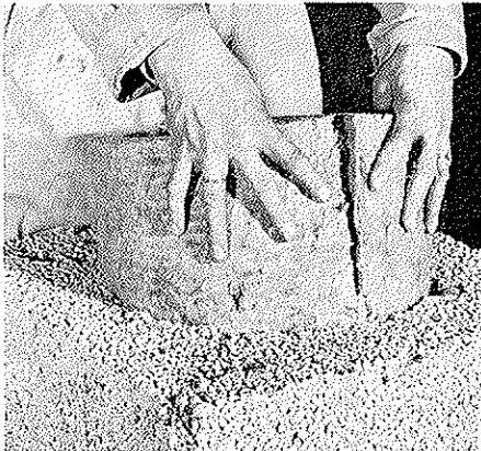
Fig. 4. Mineralullens plasseres og skyves ned med montasjelokket.
