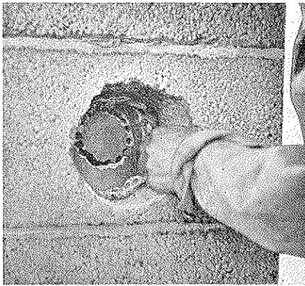
Fig. 10. Mineralull fjernes i hullet — det bores i pipeforingen og skjæres ut med bau-filblad.
