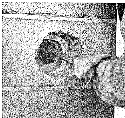
Fig. 11. Åpningens kanter slipes godt slik at røyken får en myk overgang.
