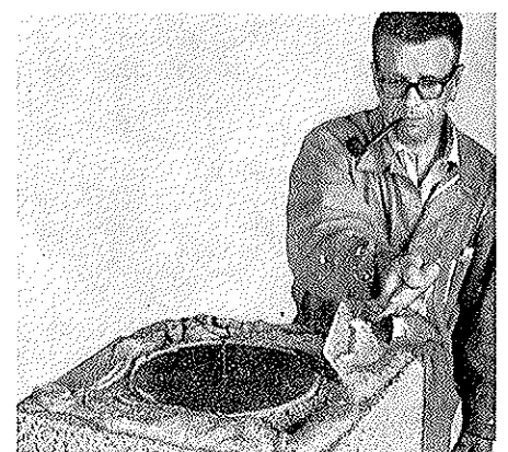
Fig. 6. Montaselokket legges oppå for å oppta mørtelspill fra videre muring.
