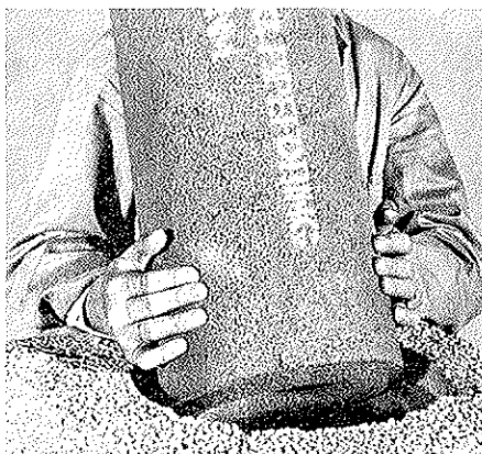
Fig. 5. Pipeforingen (60 cm) settes på plass slik at skråkanten passer i den nedenfor.
