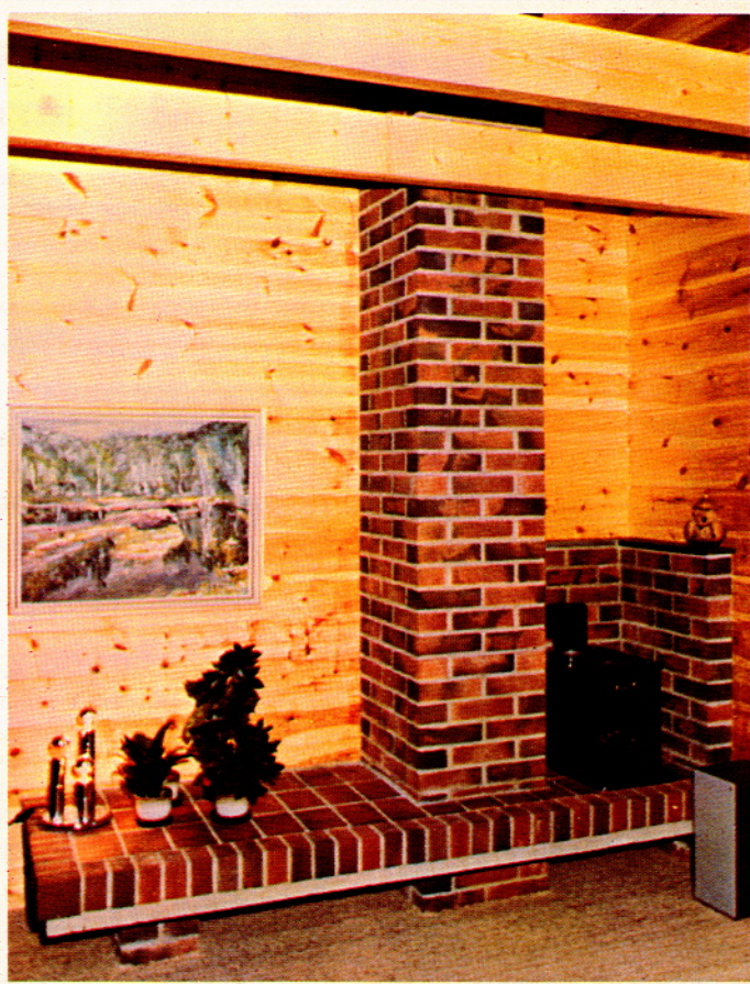
GG pipen i fuget murverk
