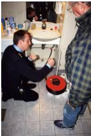
Bilde viser Feiermester L. Herneback som demonstrerer bruk av brannslange i en omsorgsbolig. øEkstra fokus på hjemmeboende pleie- og omsorgstrengende.
