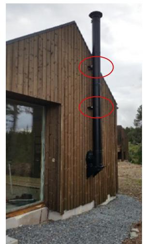
Komplett installasjon av A-pipe. Det må monteres veggfester 1 stk. pr. 3 meter.
