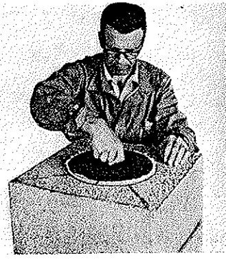
Fig. 4 Mineralullforingene (3 stk. pr. element) skyves ned med montaselokket.
