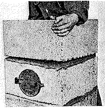
Fig. 3 Det mures 3 stk. Leca-elementer oppå feielukeelementet.
