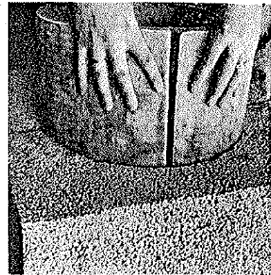
Fig. 4 Mineralullforingene plasseres og skyves ned med montasjelokket.
