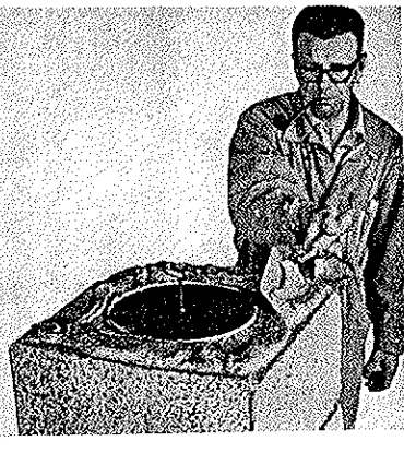
Fig. 6 Montaselokket legges oppå for å oppta mørtelspill fra videre muring.
